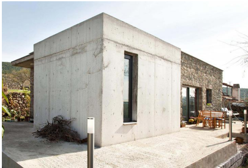
Şekil 4. Betonarme+Taş Malzeme Kullanımı
