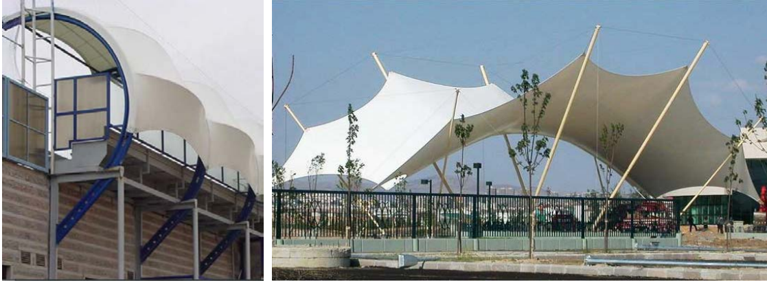
Şekil 10,11. Gergi Giydirme Cephe Asma-Germe sistemlerde tekstil kullanımı:Membran ( http://www.texlon.com.tr/ )
