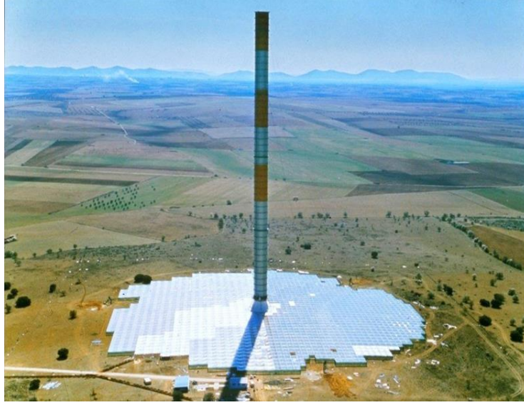
Şekil 2. Manzaneres Güneş Bacası (Kasaeian vd., 2017)
